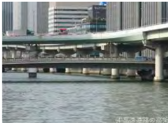
④ 高速道路の高架
