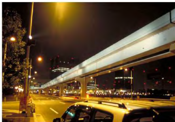
対岸から紅速道路の側面をライトアップしている事例
