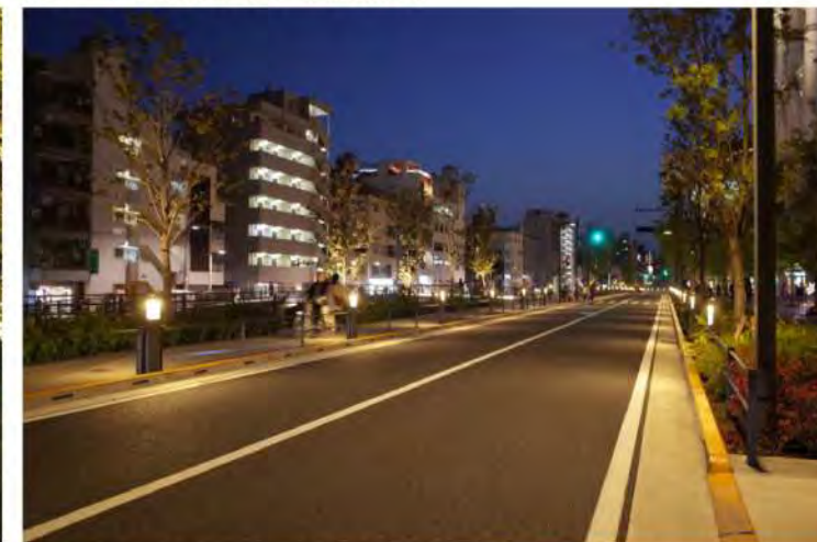
低位置の車道照明で周辺の光環境と一体になっている事例
