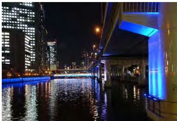
橋梁をライトアップしている事例
